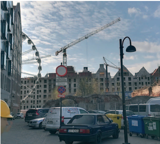
Przygotowania do wizyty na placu budowy
